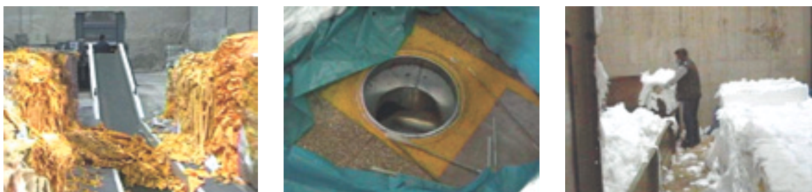
Figura 3.3. Configuraciones de puesto de apertura de balas con teleras de alimentación y boca de aspiración.
