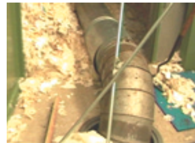
Figura 3.13. Codera acoplada a la boca de aspiración.
